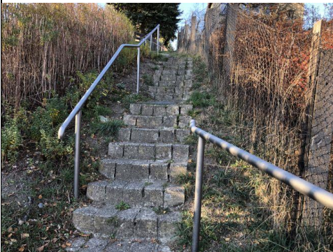
Verbindungsweg mit Treppenanlage zwischen Johann-Sebastian-Bach-Straße und Bahnhofstraße
