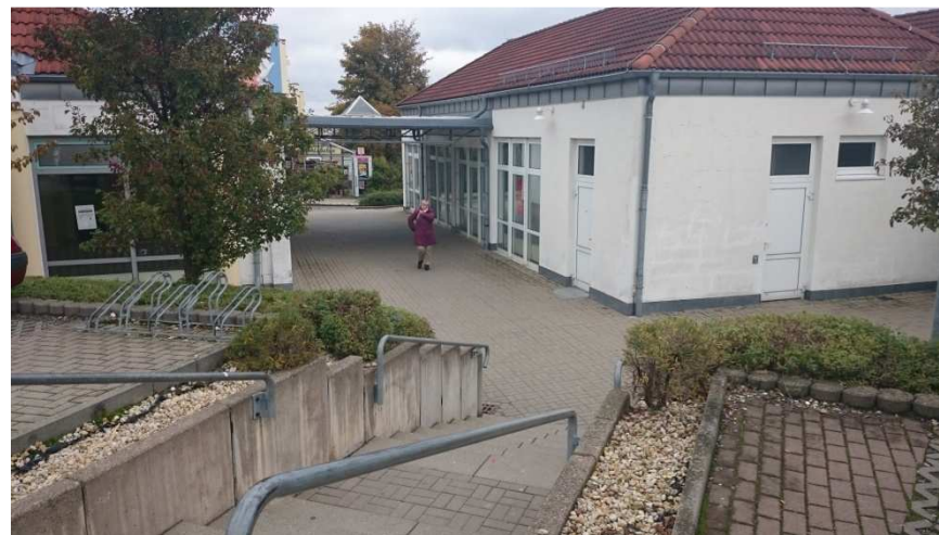
Foto 30: Geländesprünge und fehlende Barrierefreiheit im NVZ „Am Bendelstein“
