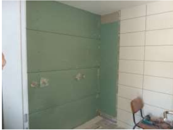
Sanitärbereich (1. Umkleide) – zum Besichtigungszeitpunkt Durchführung von Sanierungsarbeiten
