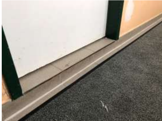
Zugang Umkleiden mit Schwellen
