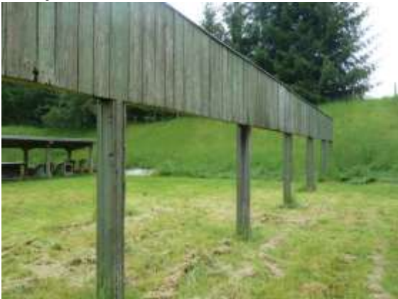
Schießelemente und Böschung rechts (Richtung Straßenbauhof)
