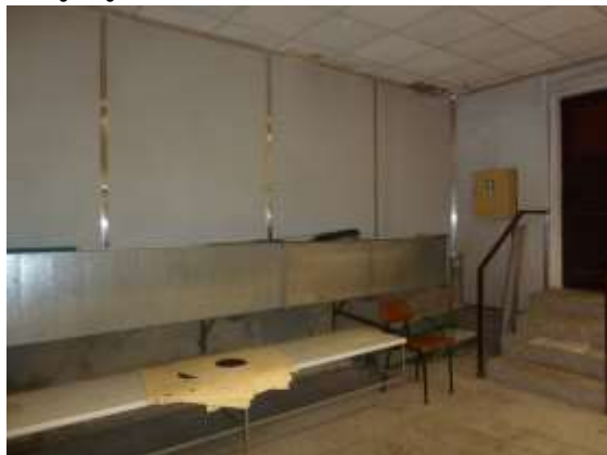
Lüftung im Bereich des Schießstandes (Notausgang)
