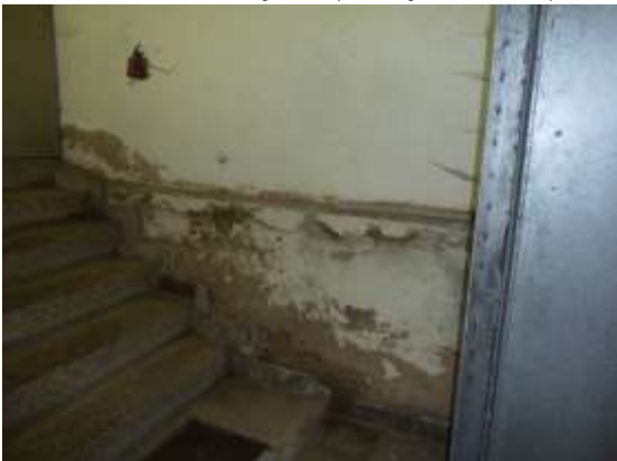
Sockelbereich an der Zugangstreppe zum Schießstand
