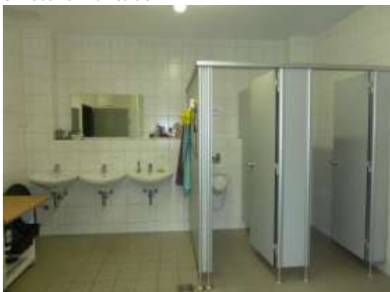
Waschbereich mit WC und Bodeneinlauf
