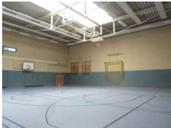
Innenansicht – westliche Stirnseite
