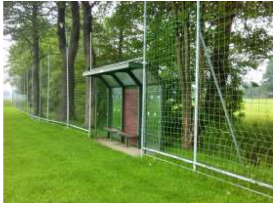
Ballfanganlage zum Bach hin mit Kabinen („Wartehäuschen“)
