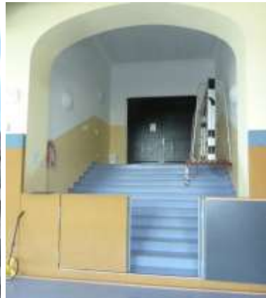
Zugang vom Schulgebäude aus
