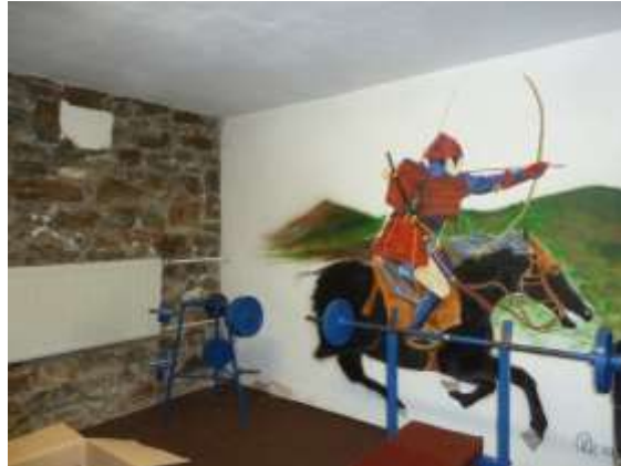
freigelegtes Natursteinmauer mit Zwangslüftung über der Heizung
