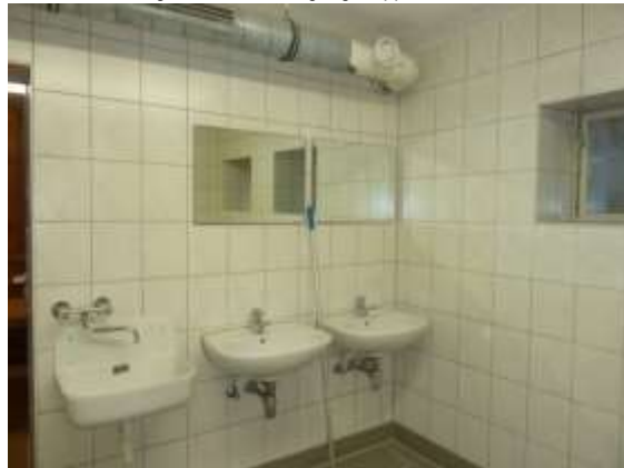
Sanitärbereich erste Umkleide
