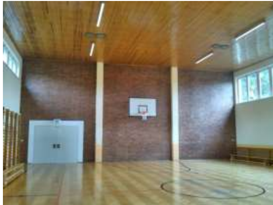
verklinkerte Stirnwand mit Notausgang
