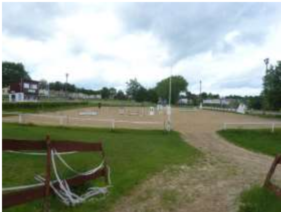
Außenansicht Einfeldhalle aus nördl. Richtung
