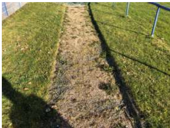
Oberflächenbelag Anlaufspur (steinig, mit Unkrautbewuchs)
