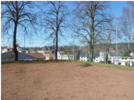
Ballfanganlage an der westlichen Ecke
