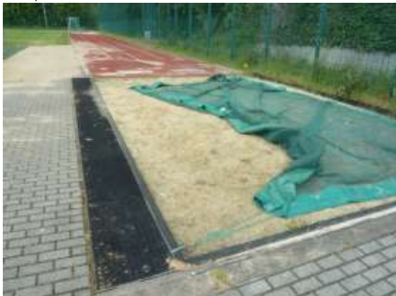
Sprunggrube mit Abdeckung
