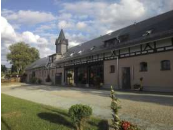
Sanierter historischer Pferdestall
