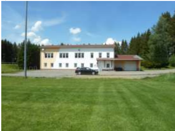
Sozialgebäude mit Umkleiden im EG
