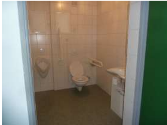
WC mit behindertengerechtem Ausbau
