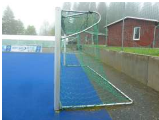
Kunstrasenbelag endet innerhalb des Torbereiches, Löcher im Ballfang
