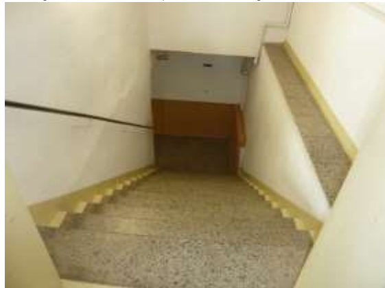
Schwelle an der Tür - Treppenanlage
