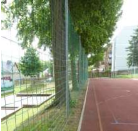
Laubbaumbestand zum Schulhof hin, OK Böschung
