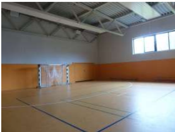
Blick nach Norden (Geräteraum)
