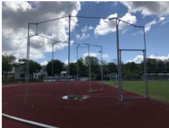
Hammer- und Diskuswurfanlage
