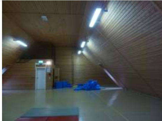
Notausgang über Außentreppeanlage
