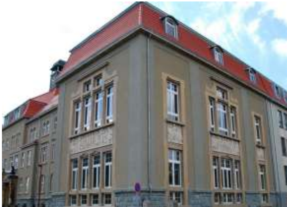
Außenansicht, Turnhalle im Erdgeschoß
