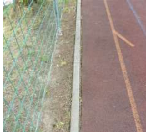
Fuge zwischen Kunststoffbelag und Betonkantenstein
