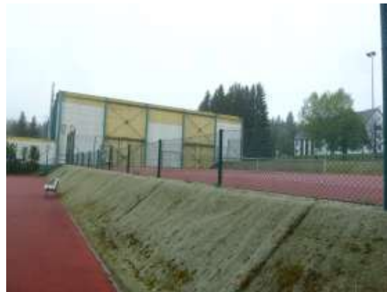
Böschungen mit Kunstrasen belegt
