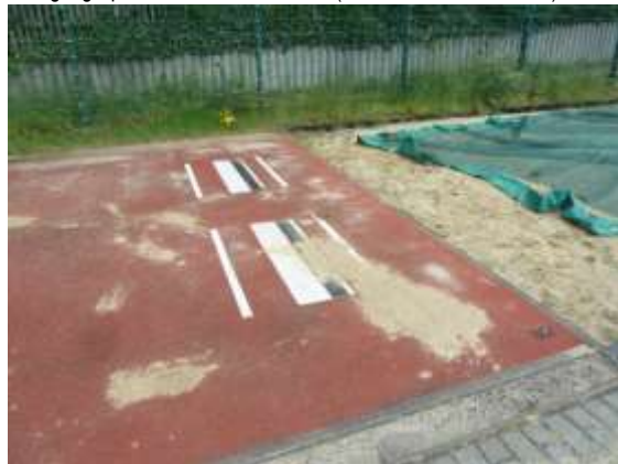
Sprungbalken höhengleich eingebaut
