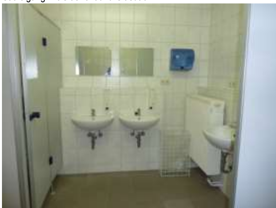
WC-Kabine und Waschbereich
