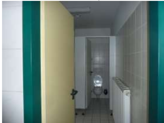
Besucher-WC (Damen/Herren und Behinderten-WC)
