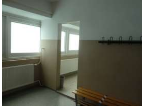
Übergang Umkleide – Sanitärbereich mit Schwelle
