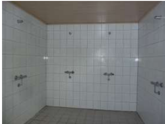
Sanitärbereich zur 1. Umkleide
