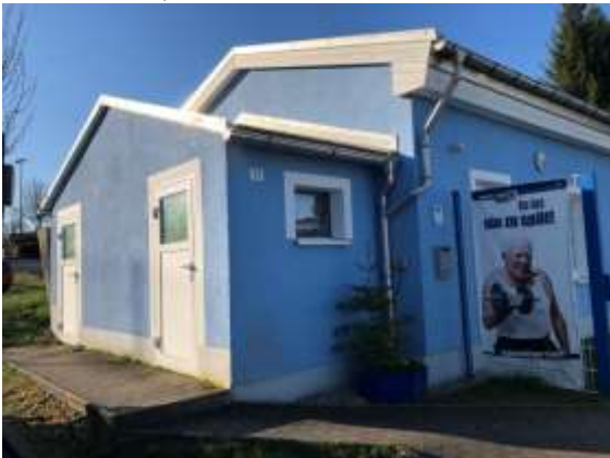
Anbau Sanitäranlagen Besucher
