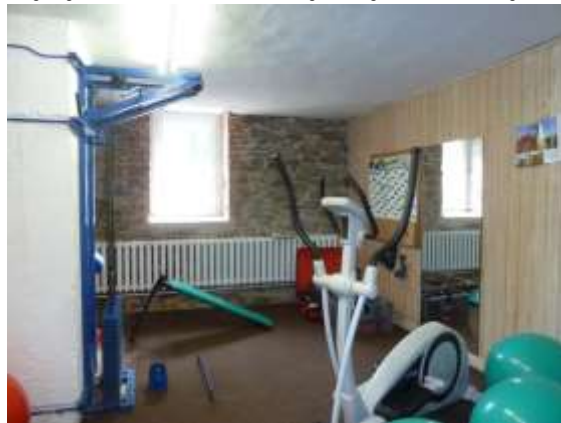
Außenwand Richtung Hof
