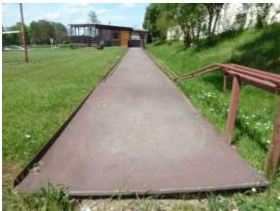
Kegelbahn mit unebener Anlaufbahn
