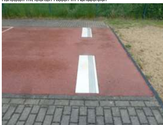
Sprungbalken aus Kunststoff, höhengleich eingebaut
