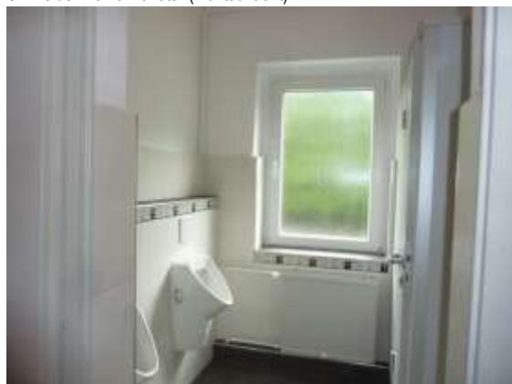
WC-Anlage mit neuen Kunststofffenstern
