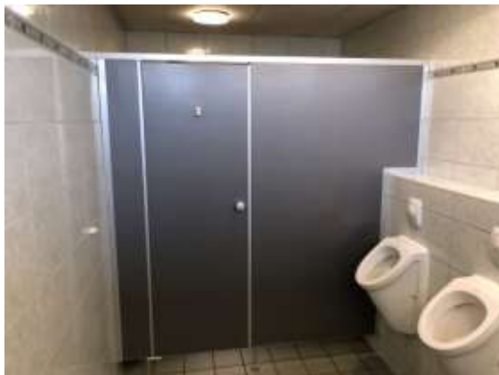
Gemeinsame Sanitäranlagen von Kegeln und Gaststätte
