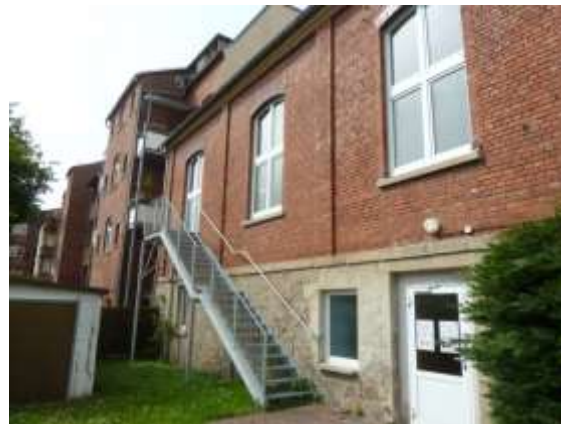
Hofansicht mit Fluchttreppe und Eingangstüre
