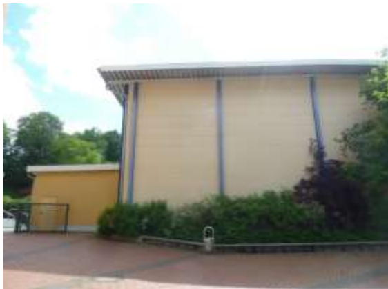
Außenansicht Zweifeldhalle vom Schulhof aus
