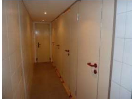
WC-Damen – Ausstattung neueren Datums, geringe Raumhöhe
