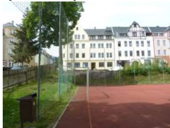
Ballfanganlage und Tor ohne Netz an der südl. Stirnseite
