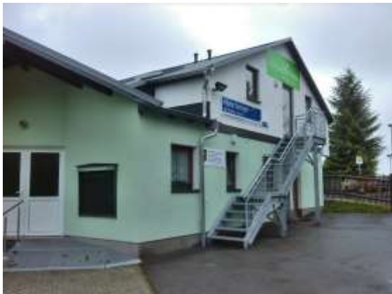
Außenansicht Haupteingang und Außentreppe zum aufgestockten OG
