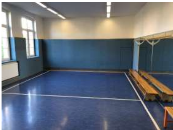
Turnraum mit sanierter Stirnseite
