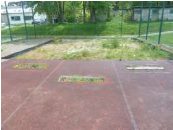
Weitsprunggrube mit fehlenden Sprungbalken (nicht mehr nutzbar)
