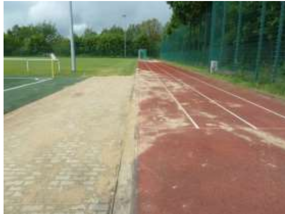
Übergang Sprintstrecke – Kunstrasen (Rinne und Pflasterfläche)
