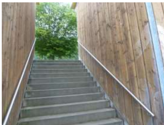
Treppenanlage zu den WCs
