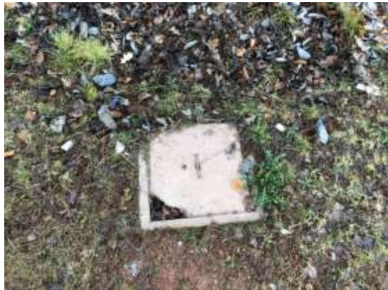
Gebrochener Drainageschachtdeckel
