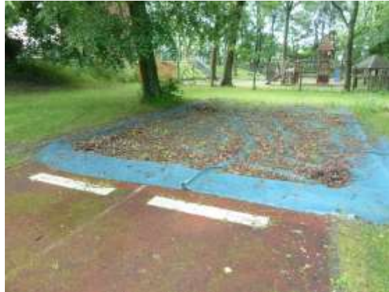
Hoher Laubanfall, Sprunggrubenabdeckung am Rand schadhaft
