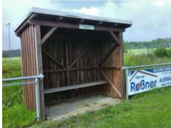
Kabine in Holzbauweise
