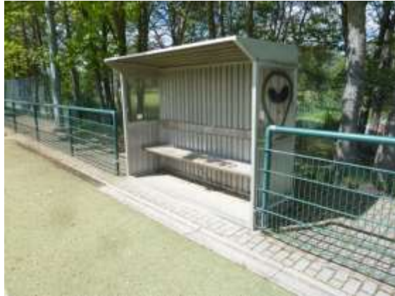
Kabine + umlaufende Barriere mit Stabgitterzaun auf der Pflasterfläche
