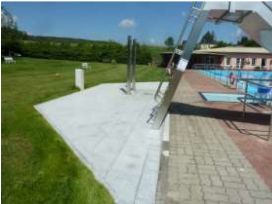
neue Dusche am zentralen Zugang und neue Edelstahlrutsch
