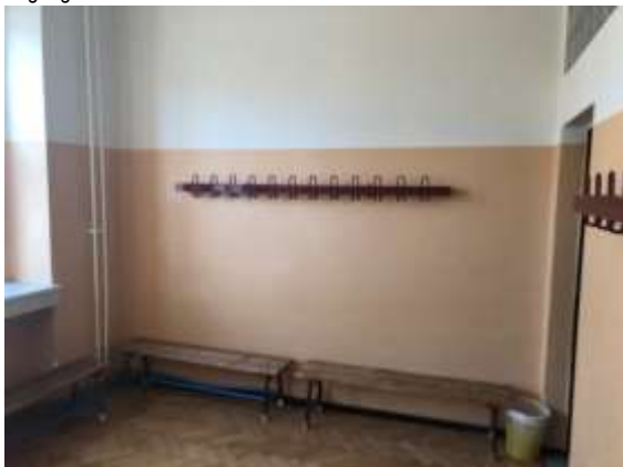
Umkleieraum mit neuen Hakenleisten, alte Bankanlagen
