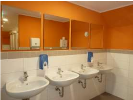
WC-Anlage im EG
