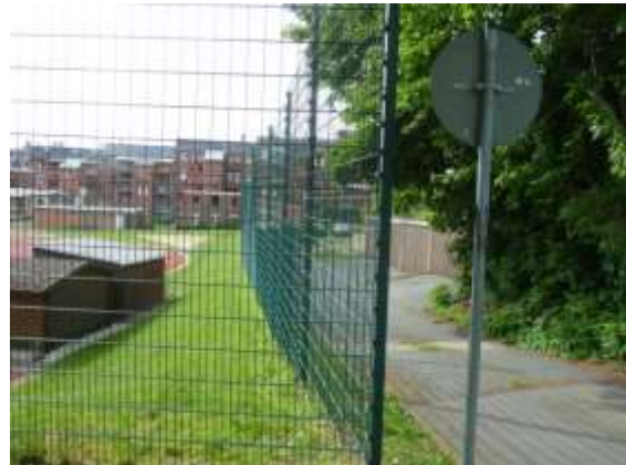
Ballfanganlage noch nicht gesichert
