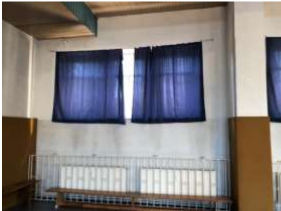
Heizungsnische mit Stahlgitter, Verschattung mittels Vorhängen
