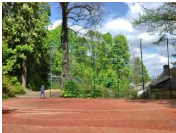
Stirnseite Allwetterplatz mit Ballfanganlage
