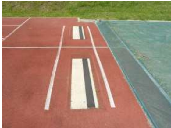
Weitsprungbalken höhengleich eingebaut
