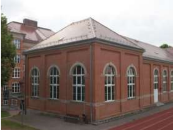
Außenansicht von Nordwesten
