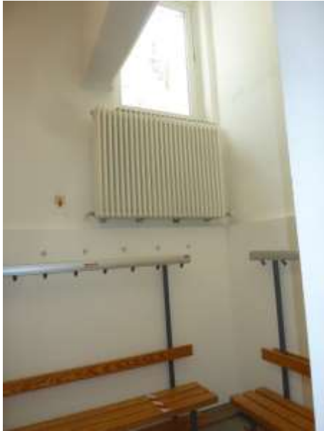
Umkleide Jungen – Außenwand nach Wasserschaden saniert
