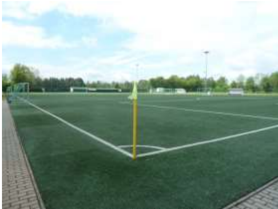
Kunstrasenplatz, Blickrichtung Südwest
