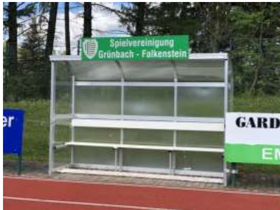
Kabine hinter der Rundlaufbahn
