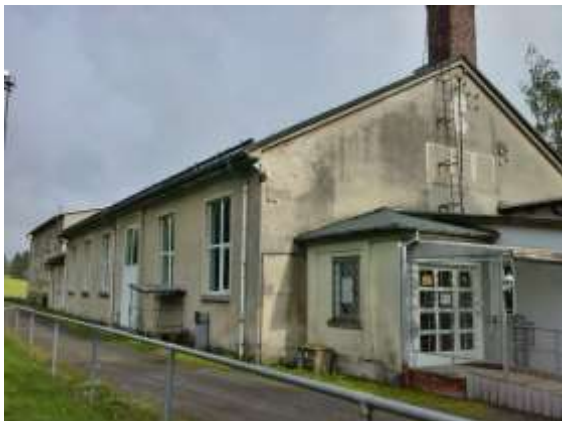
Außenansicht Einfeldhalle aus nördl. Richtung
