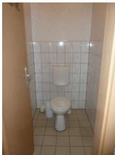
WC-Anlagen im EG
