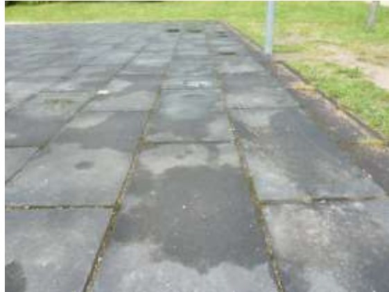
Sportbelag aus gummierten Platten aus Altreifen, Pfützenbildung
