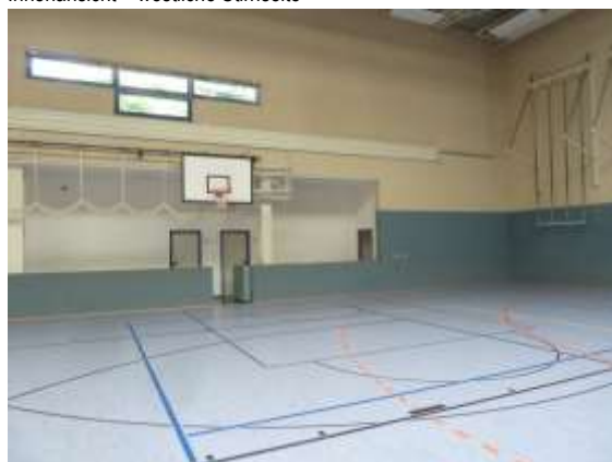
Zugangsbereich mit Bande und Ballfangnetz
