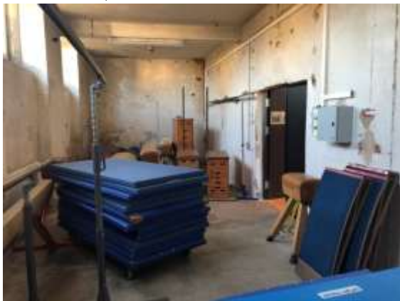
Unsanierter Geräteraum (an Stirnseite der Halle)
