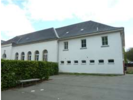
Gebäude aus südwestlicher Richtung, Zugangsbereich 2-geschossig
