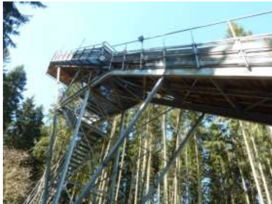
sollte Stütze eingebaut werden – K 45
