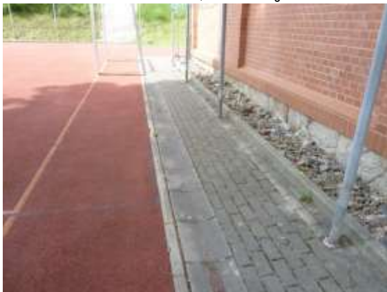
Anschluss Allwetterplatz - Turnhallenanbau
