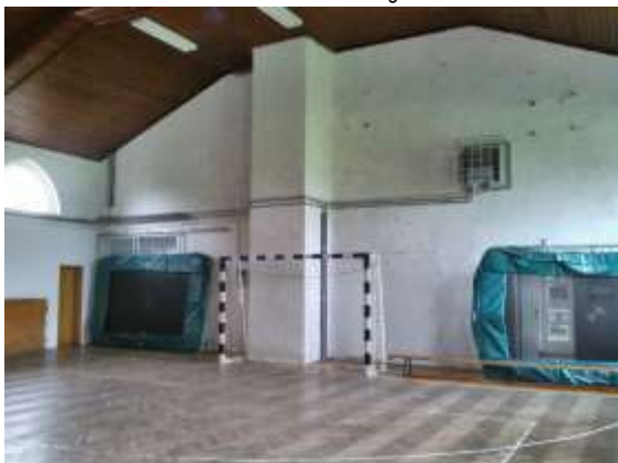
Stirnseite mit Eingang, Pfeiler ragt in den Torbereich
