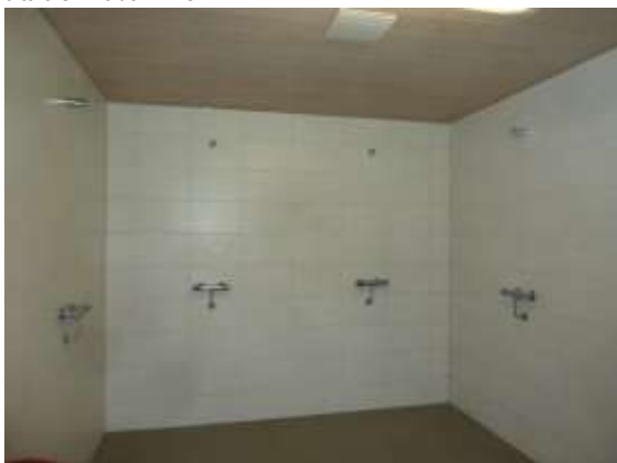
Sanitärbereich bereits saniert, zur 2. Umkleide
