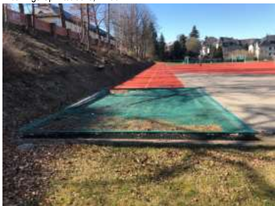
Weitsprunganlage mit Sandfangrinne und Abdeckung
