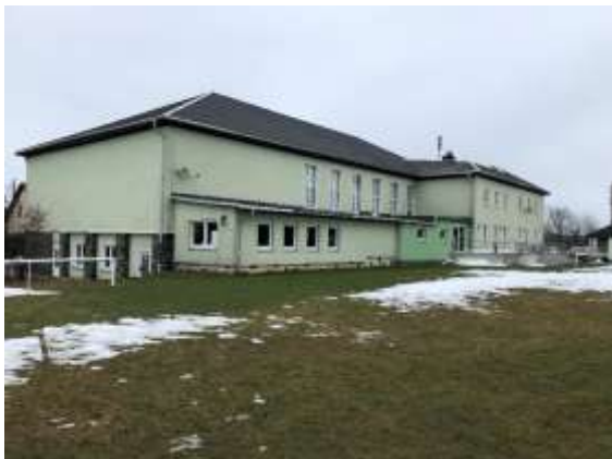
Blick auf Turnhalle
