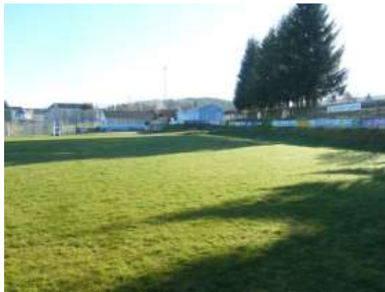
Blickrichtung Osten, Vereinsgebäude
