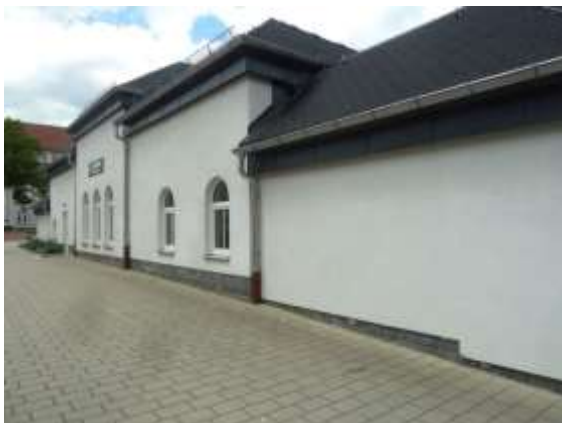
Anbau - Umkleiden und Taekwondo-Raum
