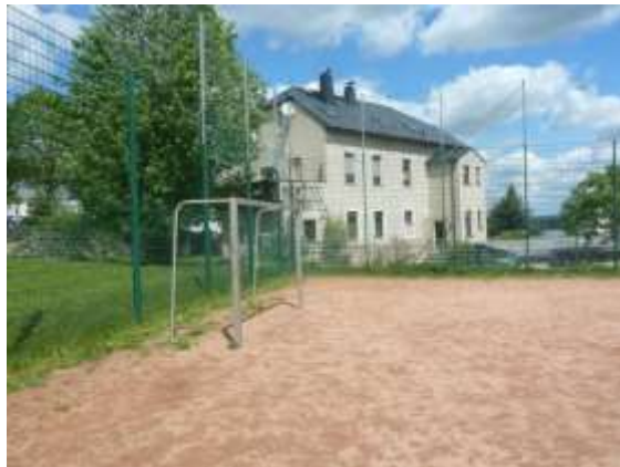
Ballfanganlage im Bereich zur Straße erhöht, Unkrautbewuchs am Rand
