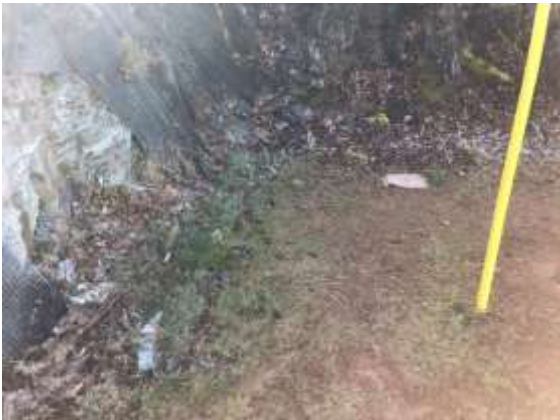
Böschung an der östlichen Ecke
