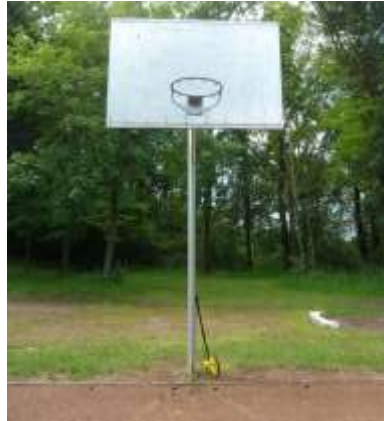
Korbanlage ohne Netze
