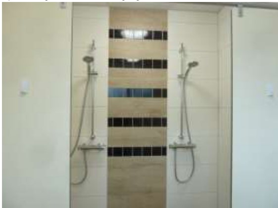
Duschbereich mit Spritzschutzwänden
