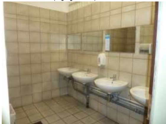
Sanitärbereich mit Waschbecken und Dusche
