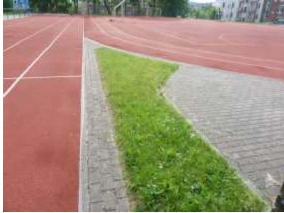
Kunststoffbelage der Anlage mit Betonkantensteinen und Pflaster
