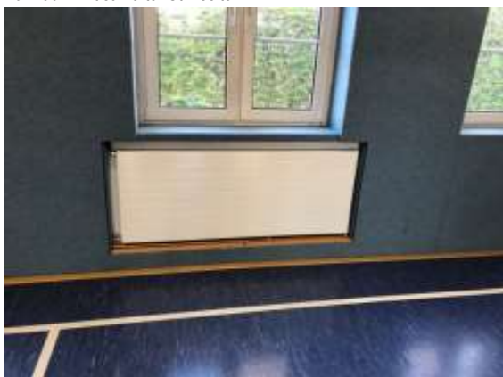
Heizung in Prallwand integriert
