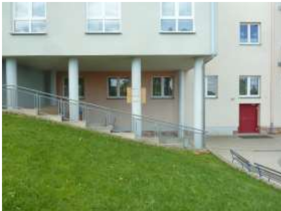
Außenansicht Turnhalle im UG des Anbaus
