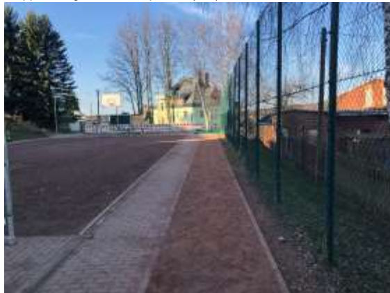
Entwässerungsrinne, Anlaufspur und Ballfangzaun
