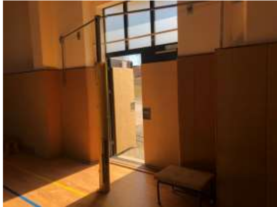
Volleyballpfosten, Notausgang ohne Kennzeichnung (mit Schwelle)
