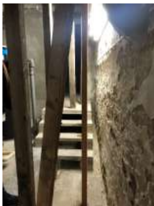
Keller unterhalb des Hauptzuganges
