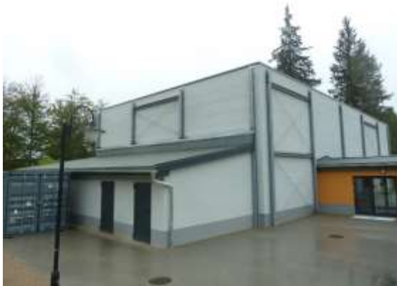
Außenansicht Einfeldhalle mit dem Geräteraumanbau
