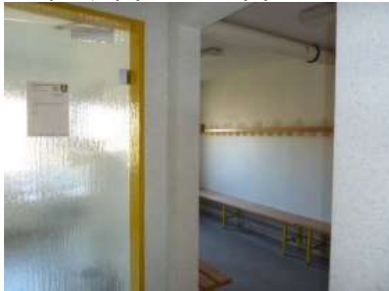
Zugang zu Umkleiden und Sanitärbereichen
