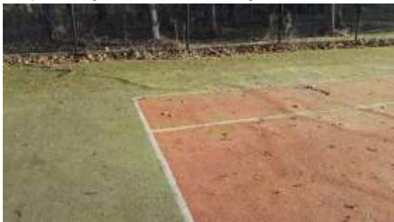
Unebenheiten / Wurzelwachstum innerhalb der Sportfläche
