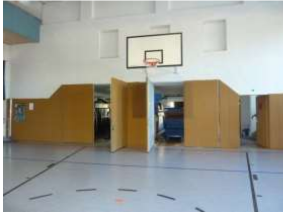
Geräteraum mit 2 Zugangstoren an der Stirnseite
