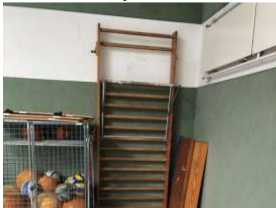
Horizontale Risse in der Außenwand
