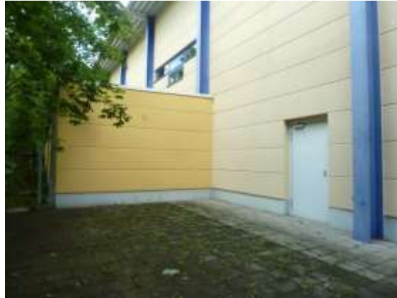
Notausgang und Anbau für die Gerätrräume
