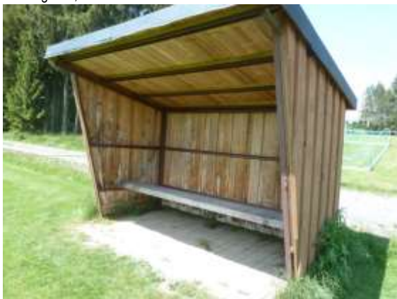
Kabine in Holzbauweise
