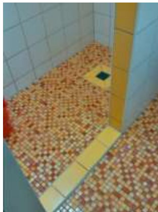
Schwelle zwischen Dusche und WC
