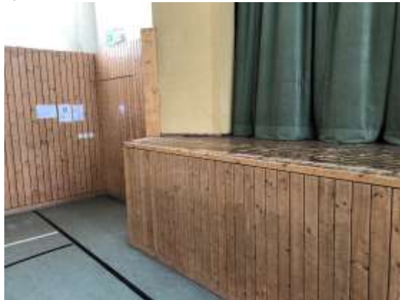
Bühnenbereich mit Ausgang Richtung Umkleiden
