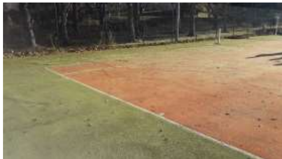
Unebenheiten / Wurzelwachstum innerhalb der Sportfläche
