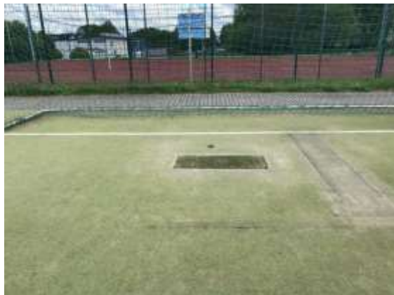
Ausbesserungen und Unebenheiten im Torbereich
