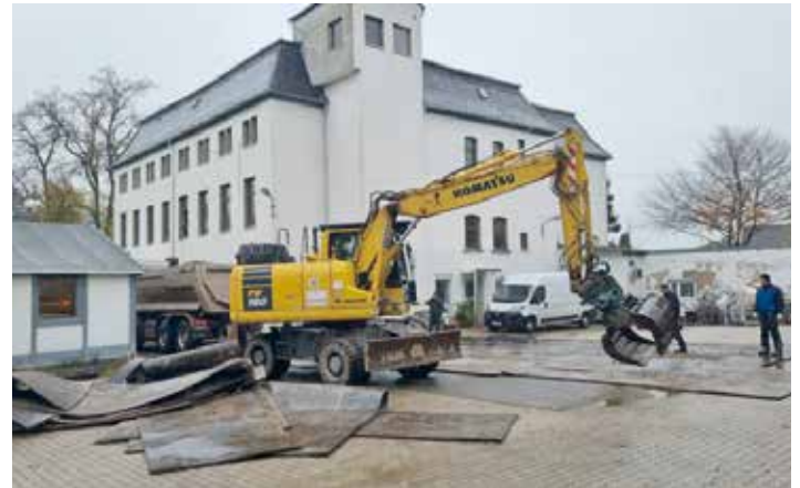
18.11.2022 Der Bagger breitet Matten rund um das Gebäude aus. Foto: Gemeindeverwaltung
