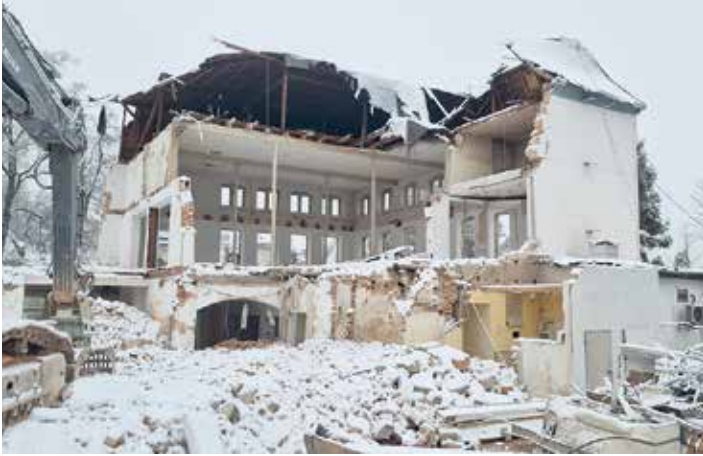
Aufnahme 04.12.2022 Abriss des Gebäudes H34 Foto: Gemeindeverwaltung
