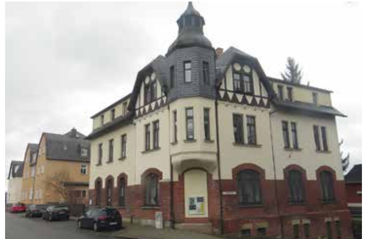
Heutige Ansicht des Gebäudes (Foto: Horst Teichmann)
