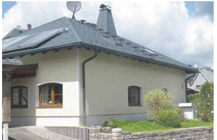
Aktuelle Ansicht Lindenstraße 40
