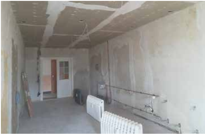
Vereinszimmer während der Bauphase
