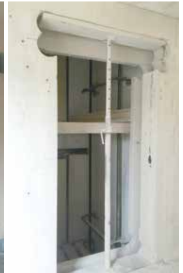
Erdgeschoss – Eingang Fahrstuhl
