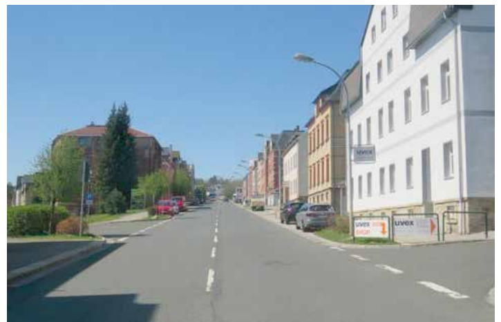
Blick in die Falkensteiner Straße 2020
