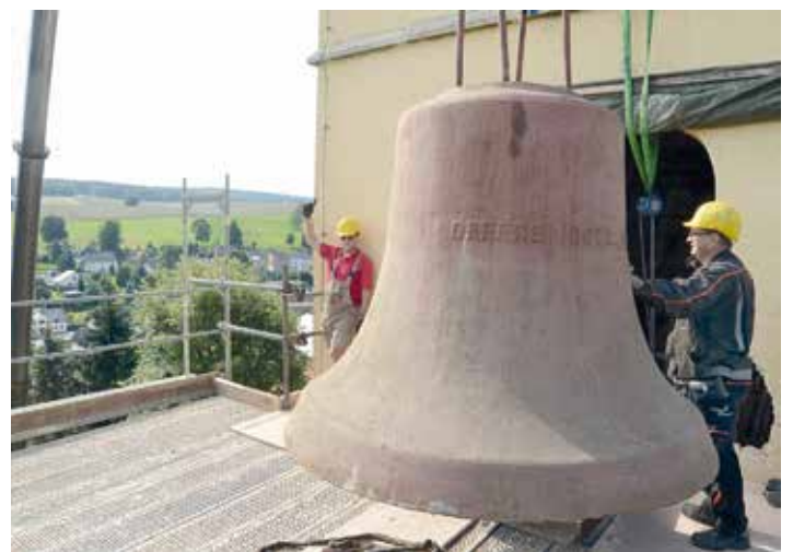
Glocke „OPFERE GOTT DANK“ schwebt am Kran. Weitere Fotos sind auch auf der Homepage der Gemeinde Ellefeld www.ellefeld.de zu sehen. Der oben stehende QR-Code weist den Weg...
