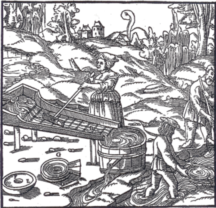
Goldwäsche an einem Fluss aus: Georg Agricola „Vom Berg- und Hüttenwesen“ (1556)
