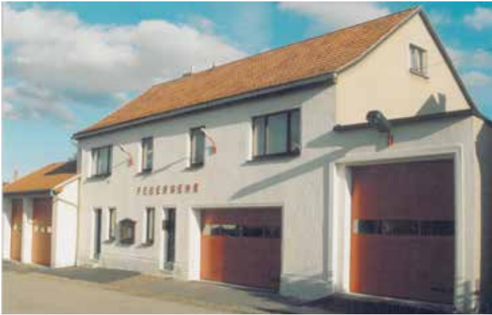
Das Gerätehaus in der Lindenstraße im Jahr 1996
