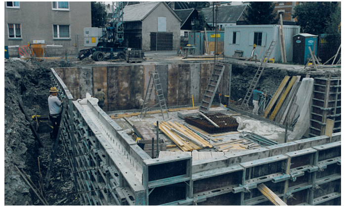
Kellergeschoss des neuen Sparkassengebäudes.
