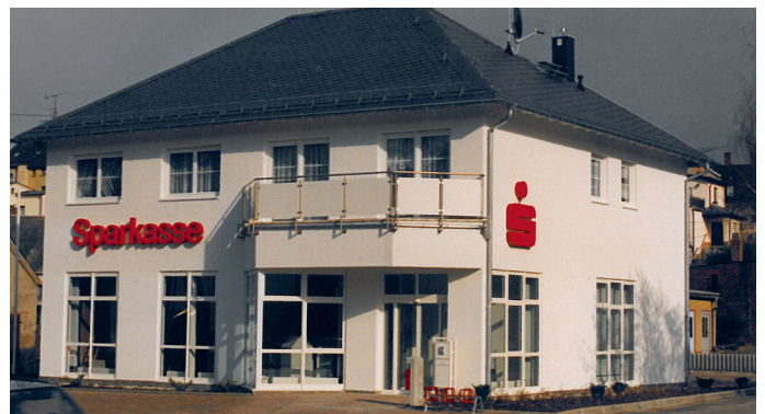
Die neue Sparkasse – fertiggestellt im März 1995.
