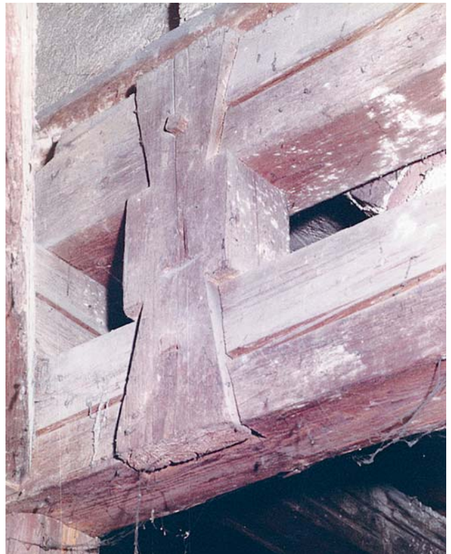
Seltene alte Zimmermannsarbeiten, sog. Andreaskreuze, sind zur Stabilisierung des Dachgeschosses im „Oberen Schloss“ zu sehen. (Foto: Bildarchiv Rieß)
