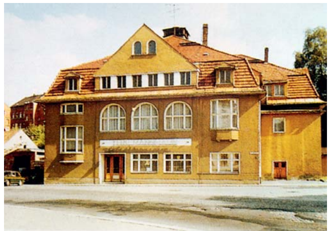
Das „Thälmannhaus“ nach der Sanierung 1972.
