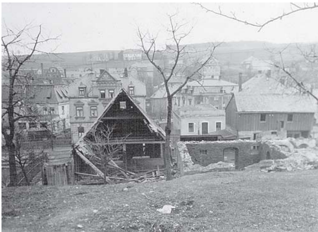
Blick von der Brandstelle zur Schulstraße.
