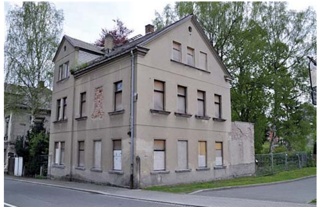
Bald ein Schandfleck weniger - Turnstraße 3. Foto: Rieß
