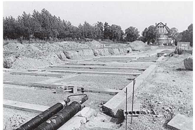
Erste Fundamente, Baubeginn Jan. 1989, Neubaugebiet Bahnhofstr., Foto: Rieß.
