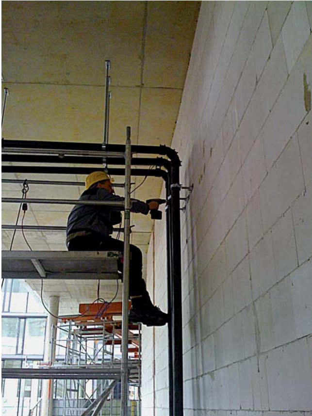
Uwe Pätz bei der Montage einer Flachdach-Druckentwässerung eines Verwaltungsgebäudes in Aachen. (Fotos: privat)
