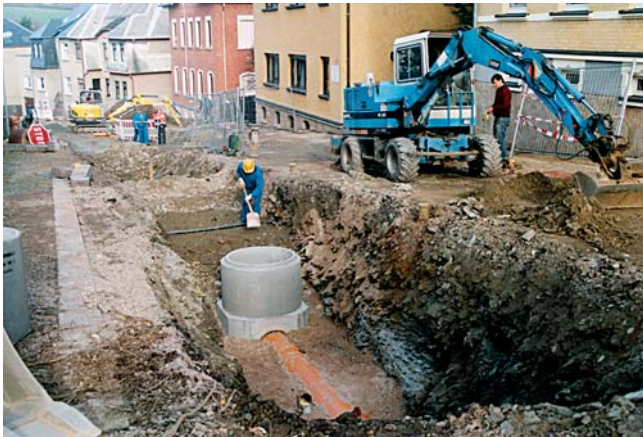
Bauarbeiten in der Hohofener Straße (Foto: Rieß). (jhüb)
