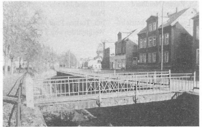
Bei der Göltzschregulierung (1925 - 34) wurden die Übergänge für Fußgänger in dieser Art gebaut.
