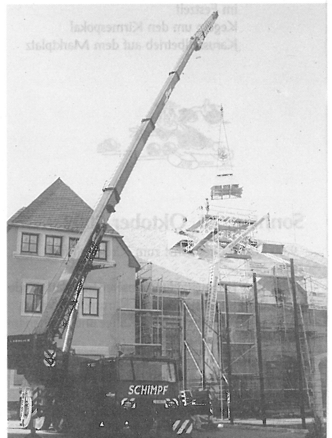
Am Freitag, dem 13.09.2002, wurde durch das Unternehmen Schimpf in Zusammenarbeit mit der Zimmereifirma Hunger der Turm auf das Dach der Jahnturnhalle transportiert und dort fertiggestellt. Fotos: Rieß.
