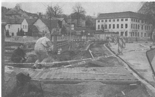
Neubau von Parkbuchten und Fußwegen.
