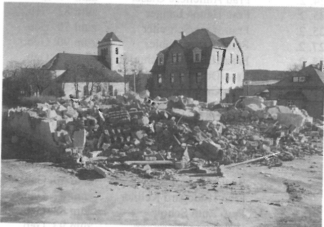
Die ehemalige Bauunterkunft am Göltzschalblick wurde in den vergangenen Wochen abgerissen. An dieser Stelle ent- steht ein Spielplatz.
