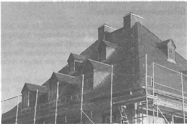
Fertigstellung der Dachsanierung. Foto: Rieß
