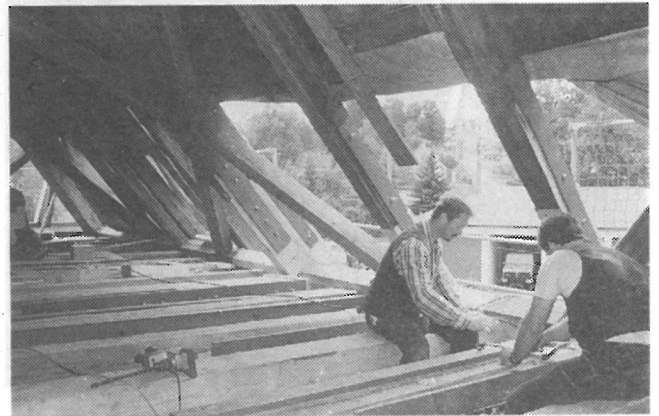
Zimmermannsarbeiten am Dachgeschoss. (Foto: Rieß)
