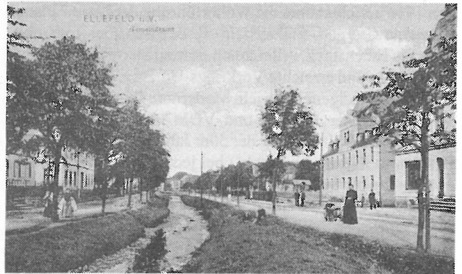
Hauptstraße in Ellefeld vor dem Ausbau.
