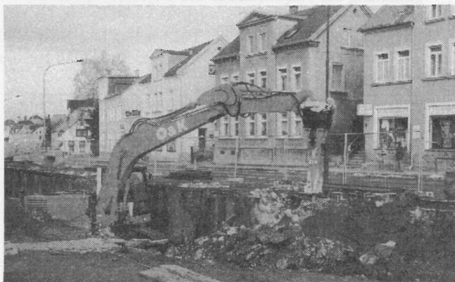
Abpickern der Ufermauern. (Fotos: Rieß)
