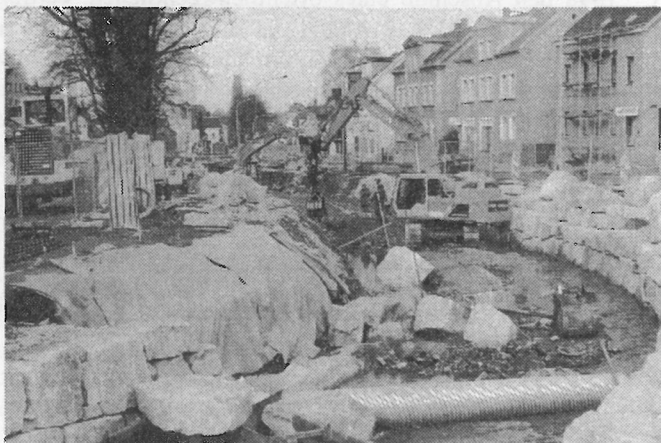
Aufsetzen der Steinblöcke.
