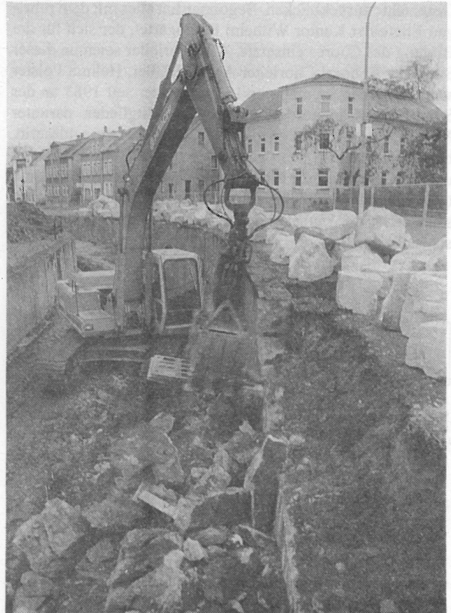
Der erste Bauabschnitt der Sanierung der Ufermauern erstreckt sich an der Lindenstraße vor der Quelle-Agentur und der Schuhmode Rieß. - Foto: Rieß
