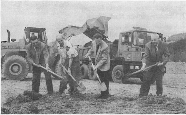
Beim ersten Spatenstich dabei: Günter Thuma, Geschäftsführer der Ellefelder Entwicklungsgesellschaft; Dieter Leicht, Bauleiter der HTI Falkenstein; Walter Blechschmidt von Jonathan-Projekt und Bürgermeister Heinrich Kerber (v. l. n. r.) (Foto: Rieß).
