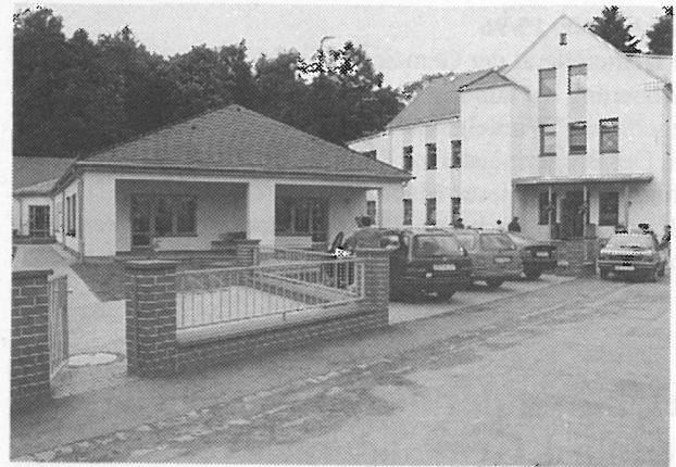
Das neue Hortgebäude mit dem Kindergarten).
