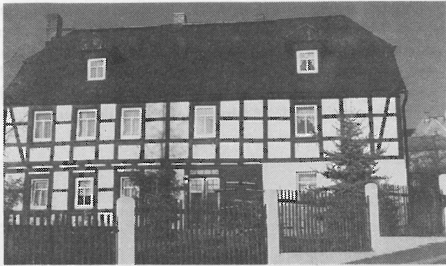
Schlichtes Fachwerk aus Tändern, Riegeln und Eckstreben am Haus Pestalozzistraße 1.
