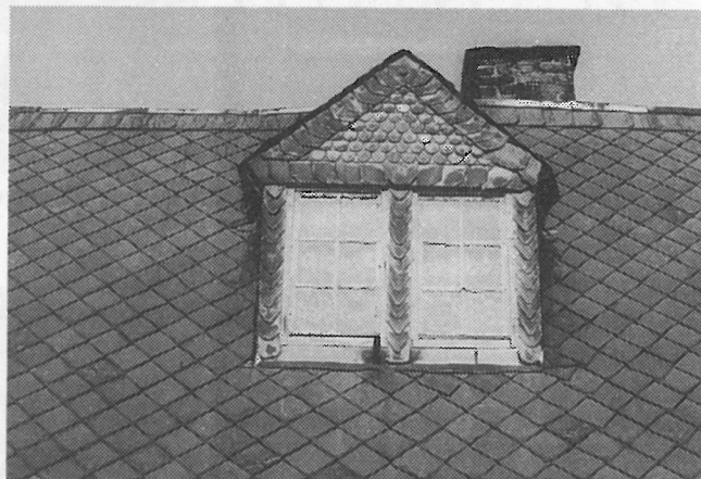
Liebevoll angefertigte Schieferverkleidung einer Dachgaube am Haus Lindenstraße 31.
