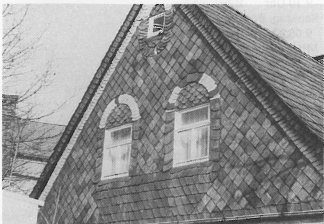
Ornamentale Schieferverkleidung am Giebel des Hauses Lindenstraße 40.
