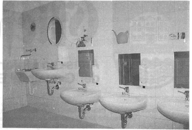
Ein Blick in die Spiel- und Sanitärräume. (Fotos: Rieß)
