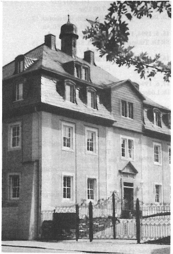
Nach der Renovierung (Foto: Thoß)
