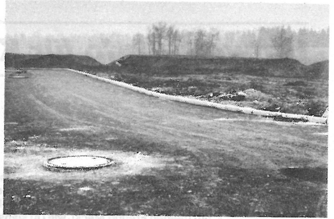
Die neue Zufahrtsstraße zum Wohngebiet "Klein-Juchhöh" Ellefeld. (Foto: Forkel)
