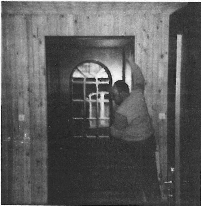
Der Meister bei der Funktionskontrolle einer eingesetzten Haustür. (Foto: privat)
