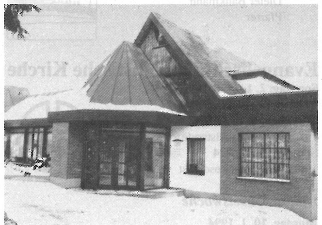
Eingang zum Verwaltungsgebäude
