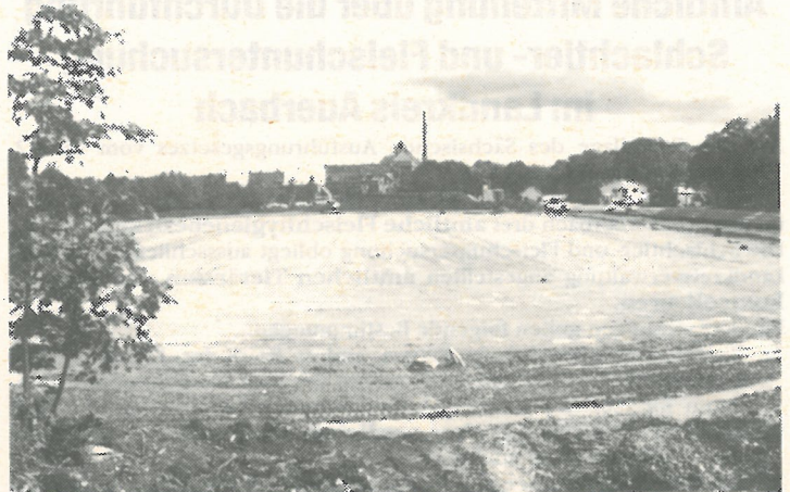
Am Falkensteiner Stadion wird fleißig gebaut
