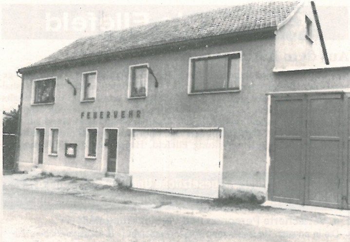
Die Kraftwagenhalle der Feuerwehr Ellefeld
