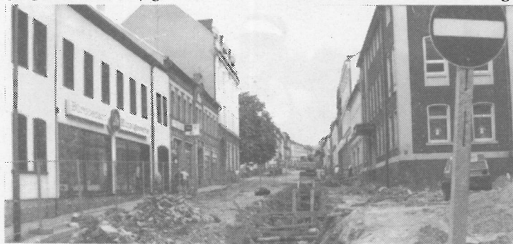
Hauptstraße wird ebenfalls komplett neu gemacht.
