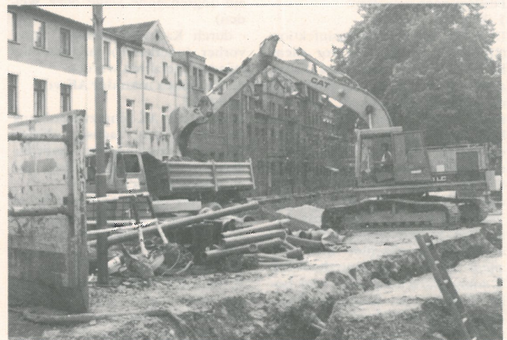
Bauarbeiten an der Oelsnitzer Straße - komplett neue Straße
